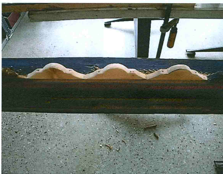
Az ágy mennyezetén lévő hiányzó csipkék kiegészítése
