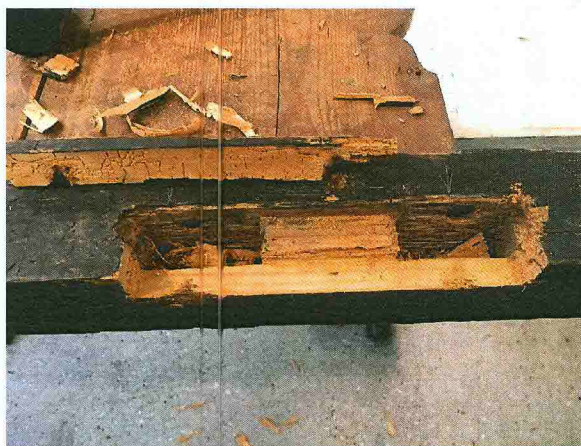
A csapok melletti sérült rész eltávolítása, betét elhelyezése, a csap statikai megerősítése
