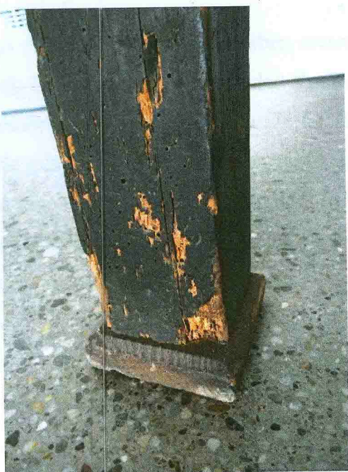
A károsodott ágylábak és csapolások
