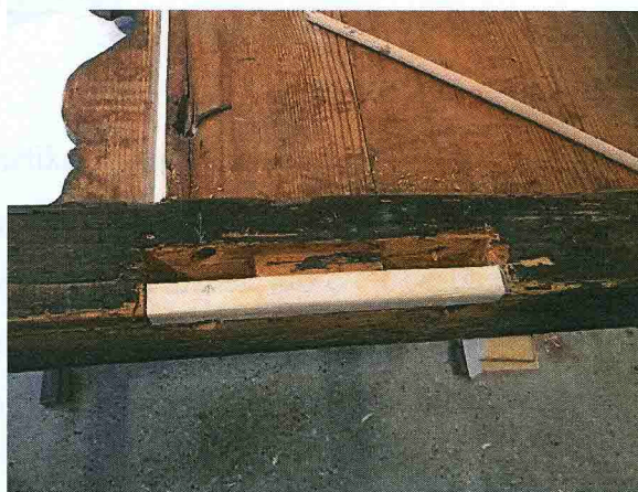
A csapok melletti sérült rész eltávolítása, betét elhelyezése, a csap statikai megerősítése
